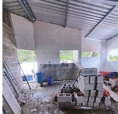
Foto 2: Reparación o sustitución de área de cocina.
