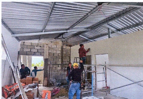
Foto 3: Reparación de Repello y sernido de paredes
