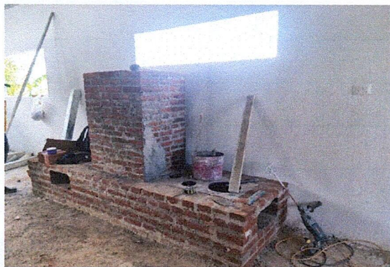
Foto 1: Reparación o sustitución de área de cocina.
