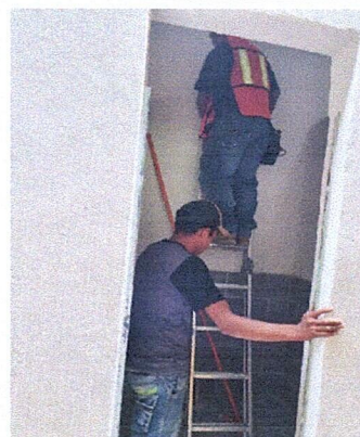
Foto 4: Reparación del Sistema Eléctrico
